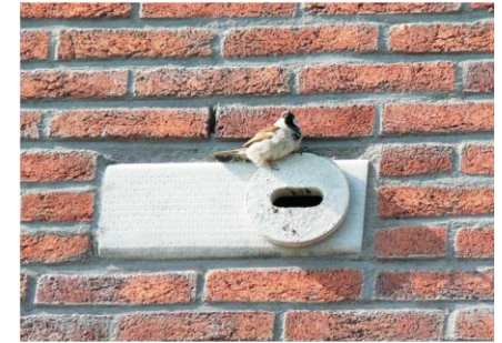
In gevel geïntegreerde nestgelegenheid voor huismussen
